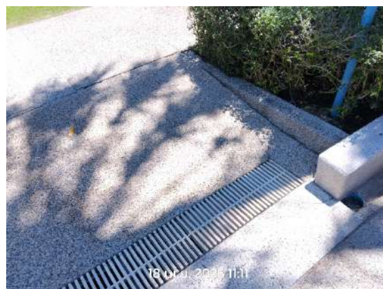
รูปที่ 2.32 รางระบายน้ำล้อมมีฝาปิดรอบสระว่ายน้ำ
